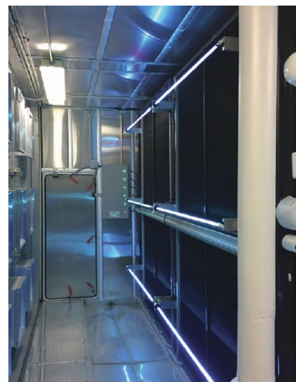
Slika 5: Fotografija vgradnje UV-C svetilk znotraj prežračevalne naprave. 5
